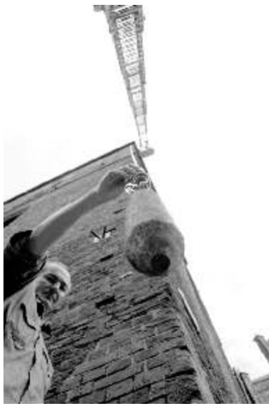
Pomiar odchyłu wieży
