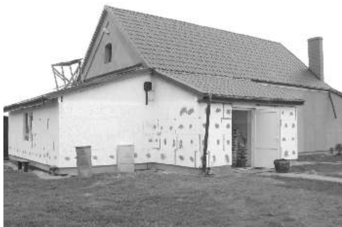
Ocieplany budynek świetlicy (tu jeszcze w trakcie prac)
