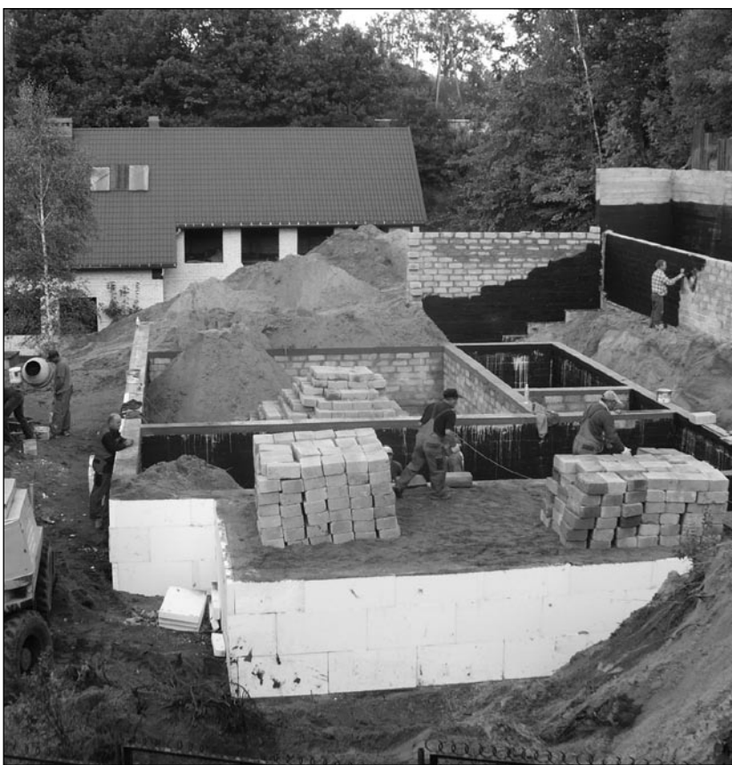
Rozbudowa Urzędu Gminy Słupsk.
