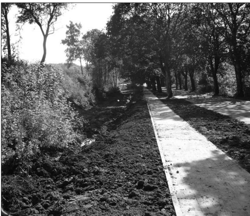
Budowa nowego chodnika ze Strzelina do Strzelinka.
