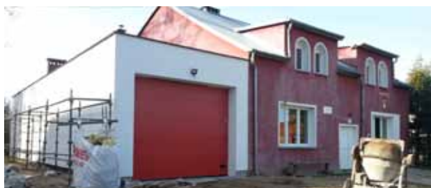
Nowy garaż dla OSP Strzelino budowany jest przy świetlicy wiejskiej. Obiekt będzie posiadał również zaplecze socjalne dla strażaków, a w świetlicy przeprowadzony został kapitalny remont.
