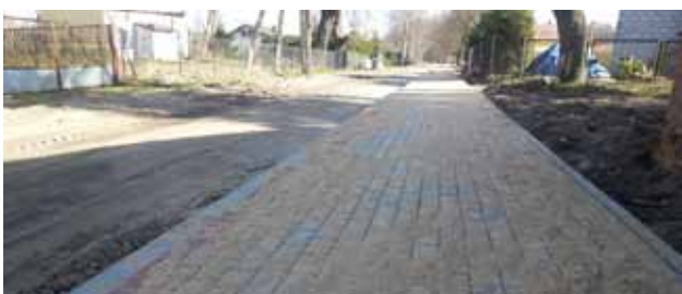
We Wrześciu powstaje nowa droga wraz z chodnikiem, parkingami i kanalizacją deszczową (od skrzyżowania z drogą wojewódzką przy ośrodku zdrowia do skrzyżowania z drogą wojewódzką na końcu wsi).
